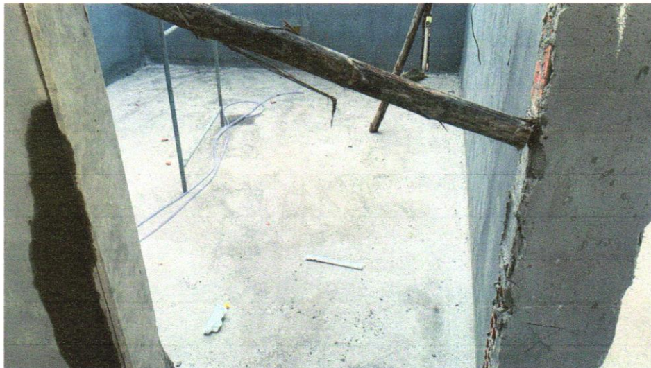
FOTO 06 – (COMPOSIÇÃO REPRESENTATIVA) DO SERVIÇO DE CONTRAPISO EM ARGAMASSA TRAÇO 1:4 (CIM E AREIA), EM BETONEIRA 400 L, ESPESSURA 3 CM ÁREAS SECAS E 3 CM ÁREAS MOLHADAS, PARA EDIFICAÇÃO HABITACIONAL UNIFAMILIAR (CASA) E EDIFICAÇÃO PÚBLICA PADRÃO. AF_11/2014
