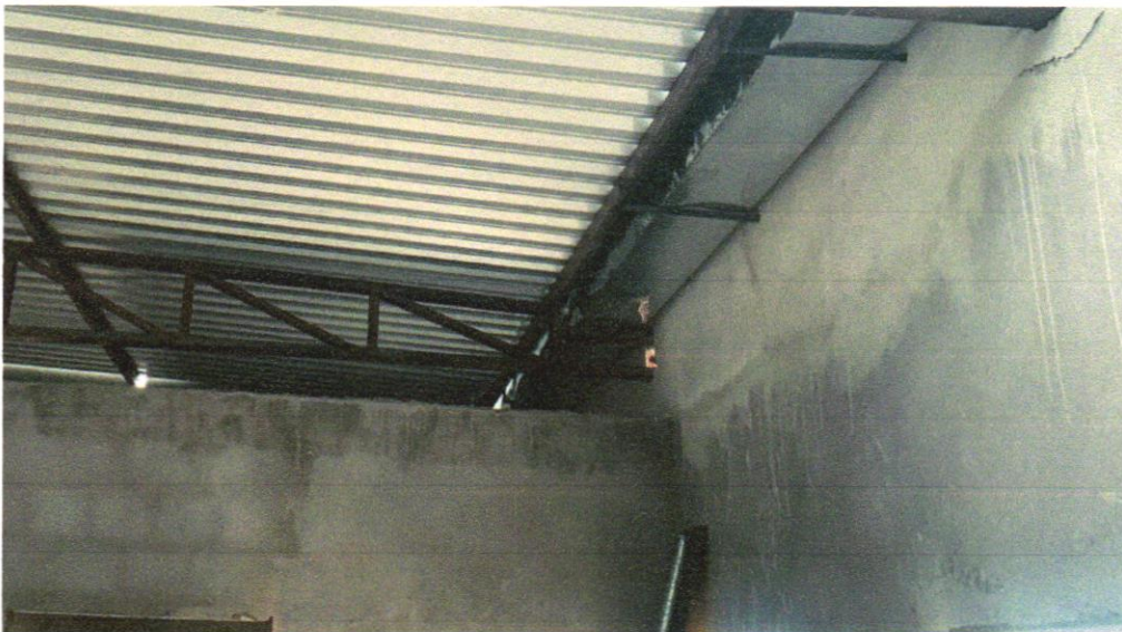
Foto - 32 - CALHA EM CHAPA DE AÇO GALVANIZADO NÚMERO 24, DESENVOLVIMENTO DE 100 CM INCLUSO TRANSPORTE VERTICAL. AF_07/2019
