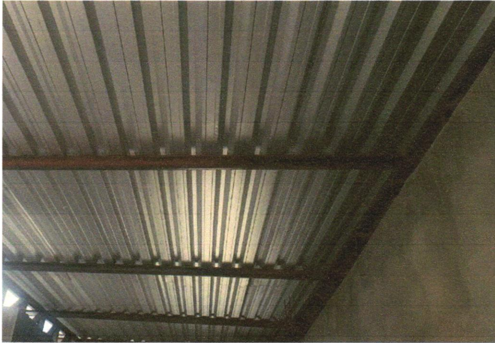
Foto 31 - TRAMA DE AÇO COMPOSTA POR TERÇAS PARA TELHADOS DE ATÉ 2 ÁGUAS PARA TELHA ONDULADA DE FIBROCIMENTO, METÁLICA, PLÁSTICA OU TERMOACÚSTICA, INCLUSO TRANSPORTE VERTICAL. AF_07/2019
