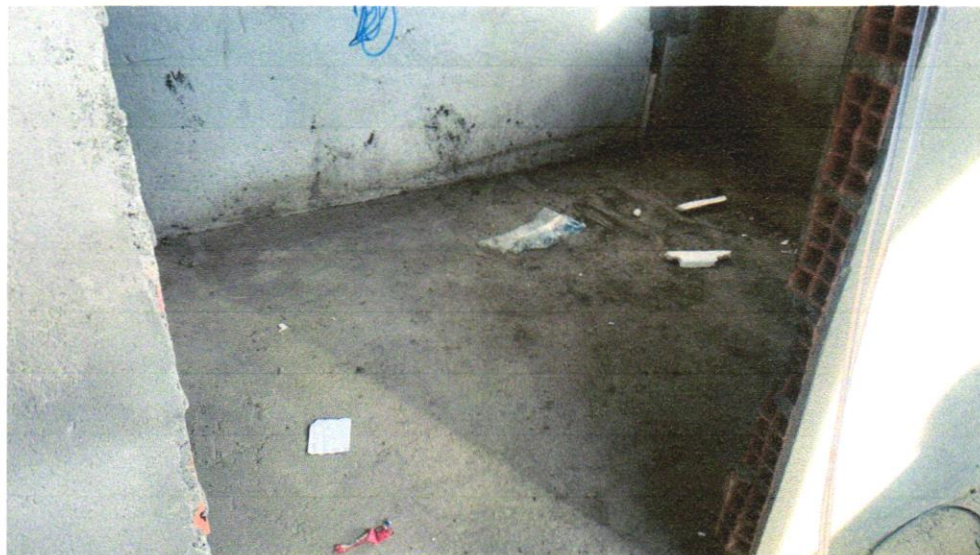
FOTO 08 - (COMPOSIÇÃO REPRESENTATIVA) DO SERVIÇO DE CONTRAPISO EM ARGAMASSA TRAÇO 1:4 (CIM E AREIA), EM BETONEIRA 400 L, ESPESSURA 3 CM ÁREAS SECAS E 3 CM ÁREAS MOLHADAS, PARA EDIFICAÇÃO HABITACIONAL UNIFAMILIAR (CASA) E EDIFICAÇÃO PÚBLICA PADRÃO. AF_11/2014
