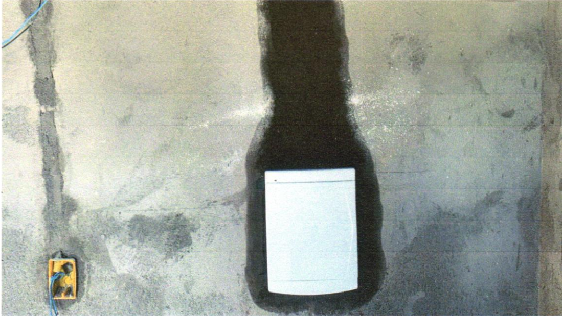
Foto 23 - Quadro de distribuição de embutir, em resina termoplástica, para até 32 disjuntores, SLIM, com barramento, padrão DIN, exclusive disjuntores
