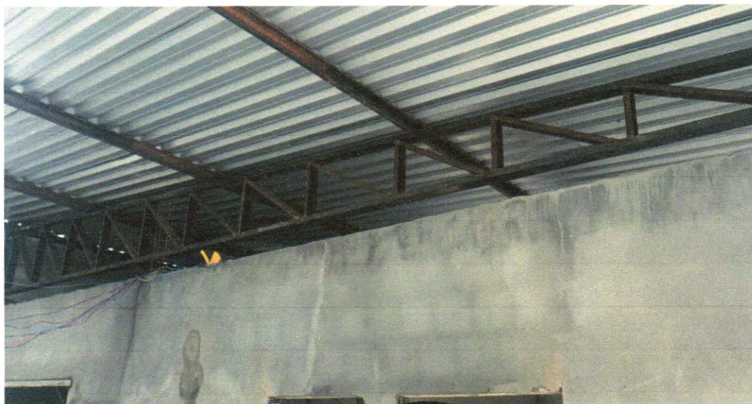
Foto 30 - FABRICAÇÃO E INSTALAÇÃO DE TESOURA INTEIRA EM AÇO, VÃO DE 10 M, PARA TELHA ONDULADA DE FIBROCEMENTO, METÁLICA, PLÁSTICA OU TERMOACÚSTICA, INCLUSO IÇAMENTO. AF_12/2015
