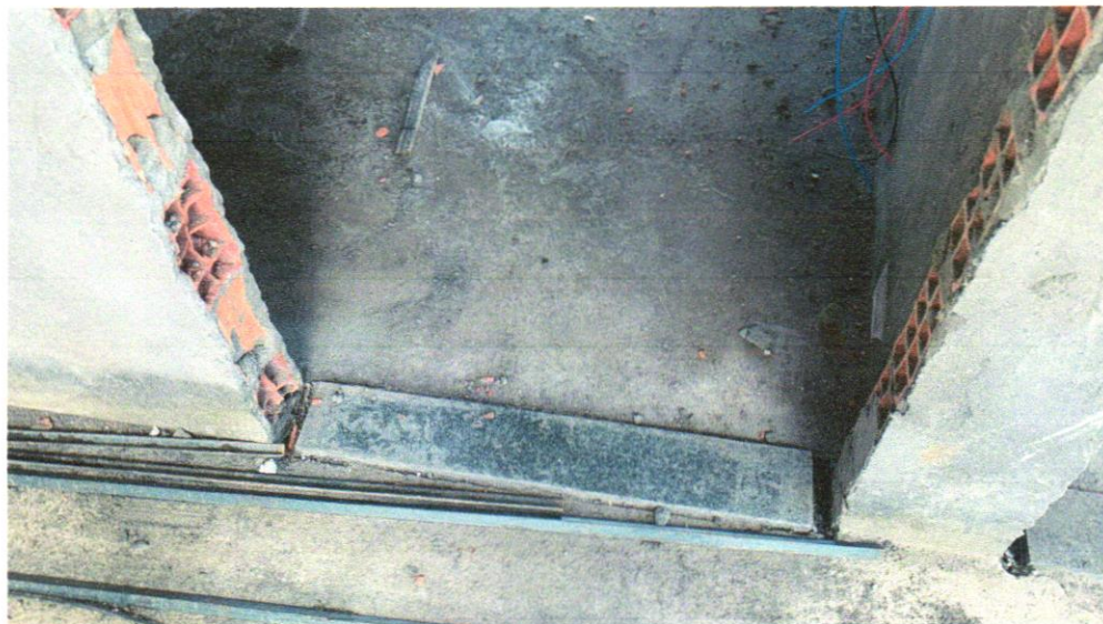
FOTO 02 – SOLEIRA EM GRANITO, LARGURA 15 CM, ESPESSURA 2,0 CM. AF_09/2020
