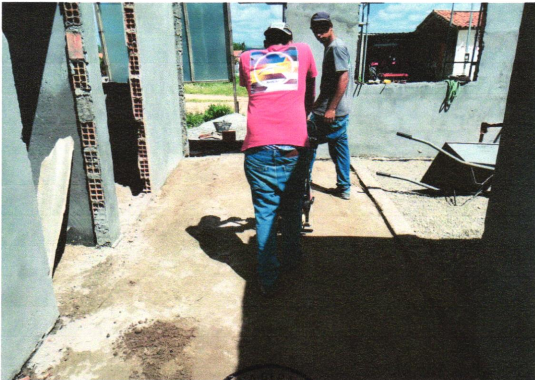
Foto 24 - Regularização mecanizada de áreas
