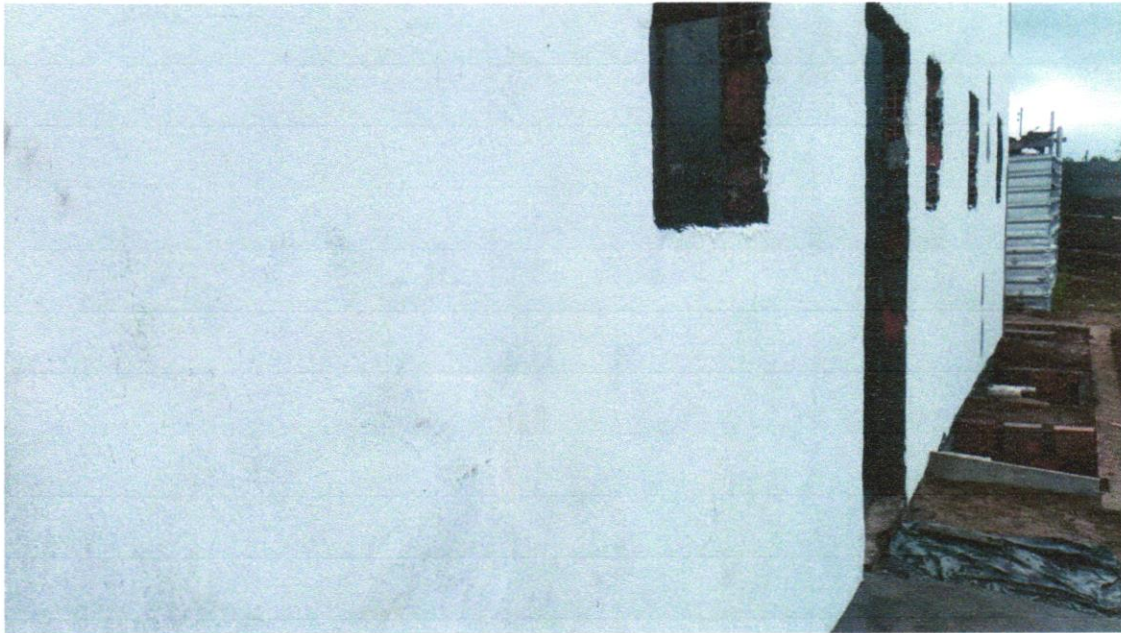
Foto 15 - APLICAÇÃO E LIXAMENTO DE MASSA LÁTEX EM PAREDES, UMA DEMÃO. AF_06/2014
