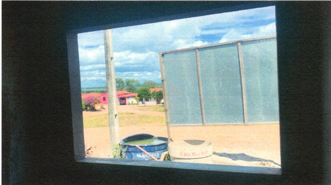
Foto 17 - PEITORIL LINEAR EM GRANITO OU MÁRMORE, L = 15CM, COMPRIMENTO DE ATÉ 2M, ASSENTADO COM ARGAMASSA 1:6 COM ADITIVO. AF_11/2020
