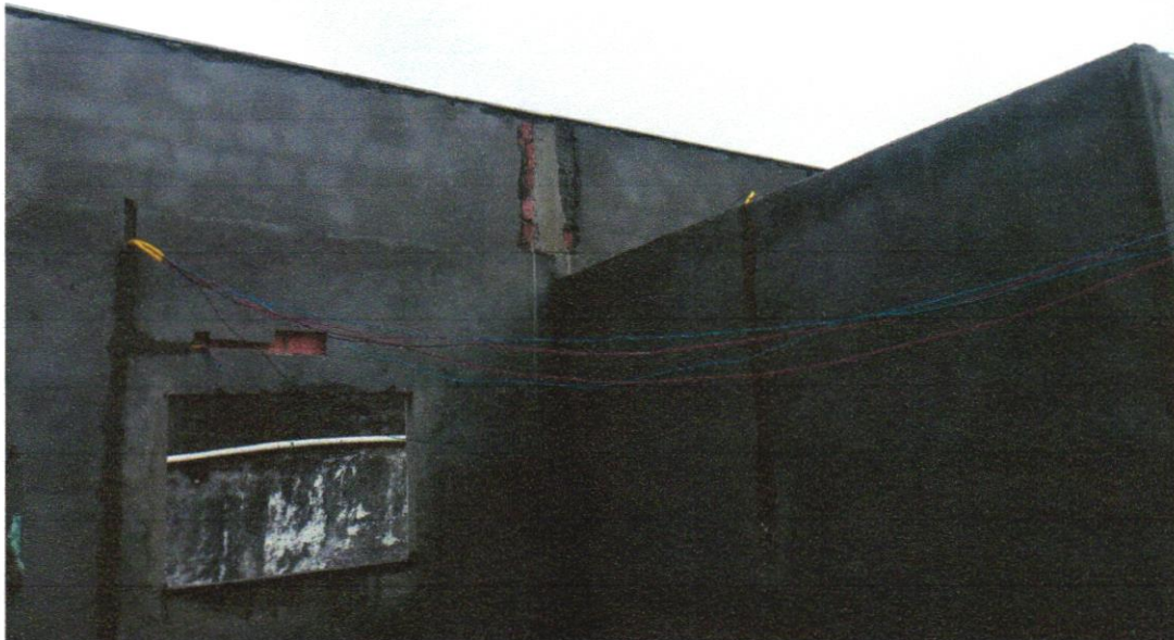
FOTO 22 - CABO DE COBRE FLEXÍVEL ISOLADO, 2,5 MM 2 , ANTI-CHAMA 450/750 V, PARA CIRCUITOS TERMINAIS - FORNECIMENTO E INSTALAÇÃO. AF_12/2015
